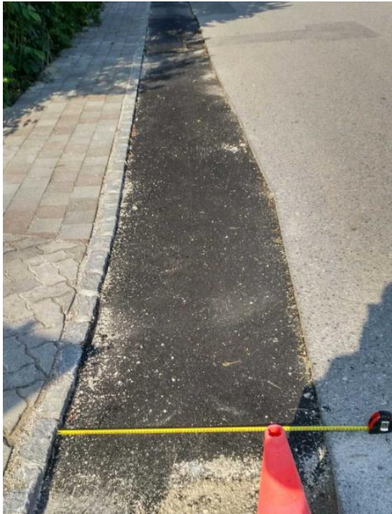
Grabung Asphalt ~120€/lfm
