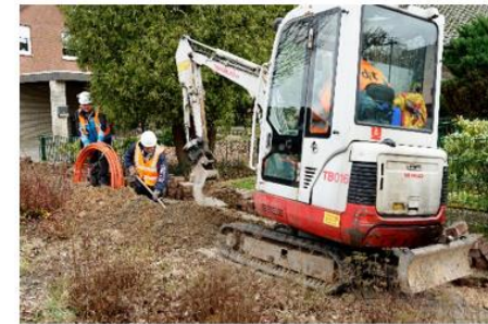
Grabenbau mit Bagger/Schaufel
