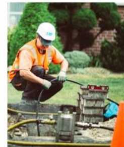
Bodenverdrängungsverfahren, ugs. Erdrakete
